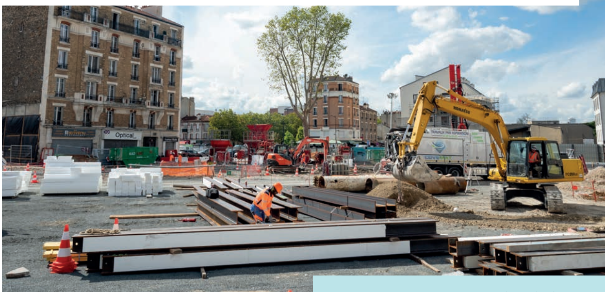
» Les travaux d'aménagement des sols ont commencé à Mairie d'Aubervilliers. Une étape indispensable pour couler les fondations de la future gare.
