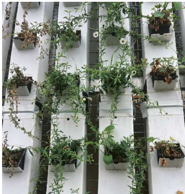
» Les murs végétalisés de Demet'Air réduiront la température du bâti de 15 C° en surface et de 5 C° en intérieur.
