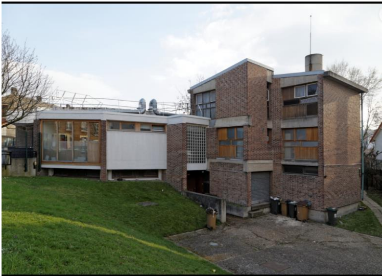
Cité des Anciens Ambroise Croizat 35-41 rue du Docteur Roux à La Courneuve (AQ0203)
